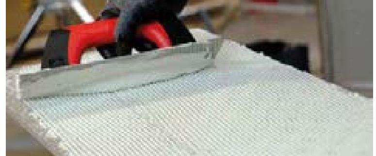
Spread the adhesive cement with a toothed trowel on the tile | Extiende el cemento de agarre con una llanta dentada sobre la pieza | Étende le ciment à prise rapide à l'aide d'une spatule dentée sur la pièce | Verstreichen Sie den Klebemörtel mit einem Zahnpachtel auf der Fliese
