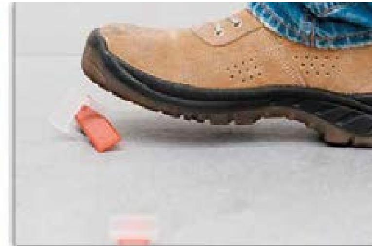
Una vez fraguado el cemento cola, para arrancar el soporte basta con golpear con el mazo de goma o con la punta del pie en la dirección de la junta.
